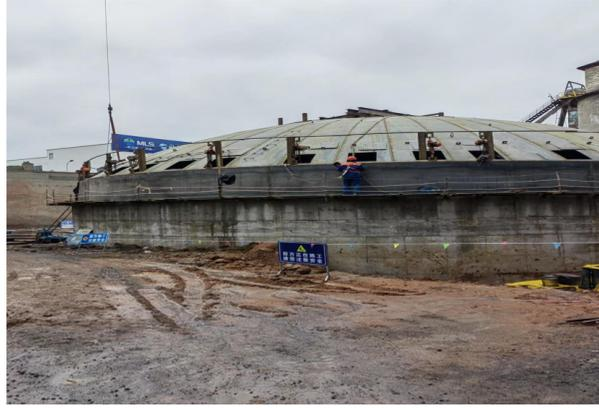
熟料库、水泥库技改的目的是：杜绝了熟料入库时的粉尘无组织排放；库存熟料质量的保证，再无浸水化、风化的影响因素；降低生产费用节约成本，减少了熟料周转环节；改善水泥生产工艺，为稳定产品质量创造了条件（多秤搭配）；质量均匀、准确计量、中间减少倒库环节、储存量更大等环保方面的改善。
