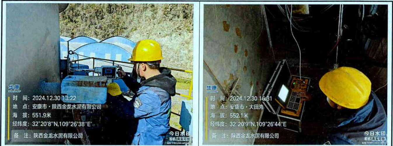
窑头废气排气筒 (DA015)
