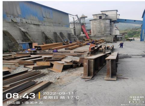
9月10日，建设施工现场机器轰鸣，起吊机不停地张开长臂，40多名奋战在施工一线的工人干劲十足，为按期完成项目建设任务而紧张地有序地忙碌着。湖北明辉公司负责土建主体结构已全部封顶交安，正在辅助工程电气室内进行电缆沟抹灰施工，辊压机房土方回填工作，负责设备安装的苏华建设公司进行钢结构钢材下料、立柱、横梁组对、喷砂人员开始进行喷砂除锈作业，其他配套工作电气室电缆沟施工、中控室施工、仓库改建、移动卫生间基础等工作同步进行穿插作业。工程过程预计10月上旬进行钢结构框架主体工程验收，11月中旬前完成设备安装后具备试车条件，12月上旬完成竹山技改项目一期的全部工作。
