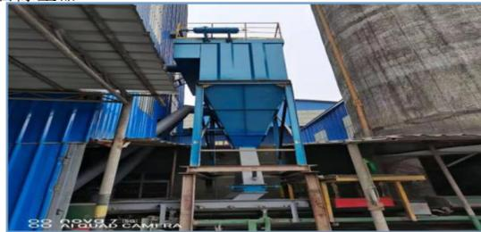
2020年12月14日至12月27日每天分配部分机修工实施该项技改工作，通过大家13天的团结合作，顺利完成了除尘器的安装工作。改善了0801斗提地坑和库底皮带头部扬尘问题。本次技改工作不仅改善了0801斗提地坑及库底皮带头部漏料问题，也减轻了巡检工在工作量，同时也为公司节约了外协单位安装费用。
