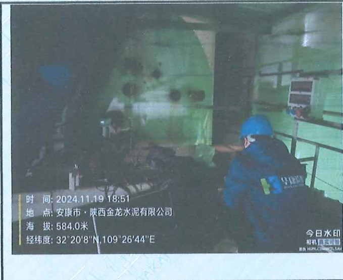
窑尾废气排气筒 (DA011)
