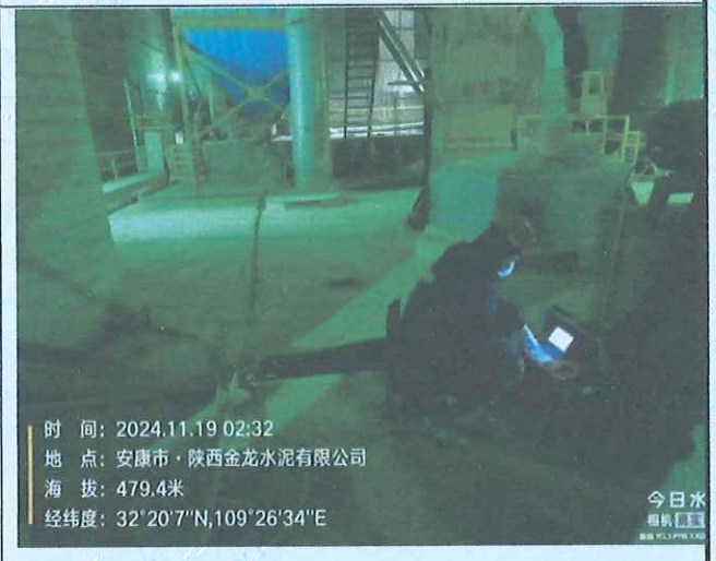
水泥高细磨废气排气筒 (DA039)
