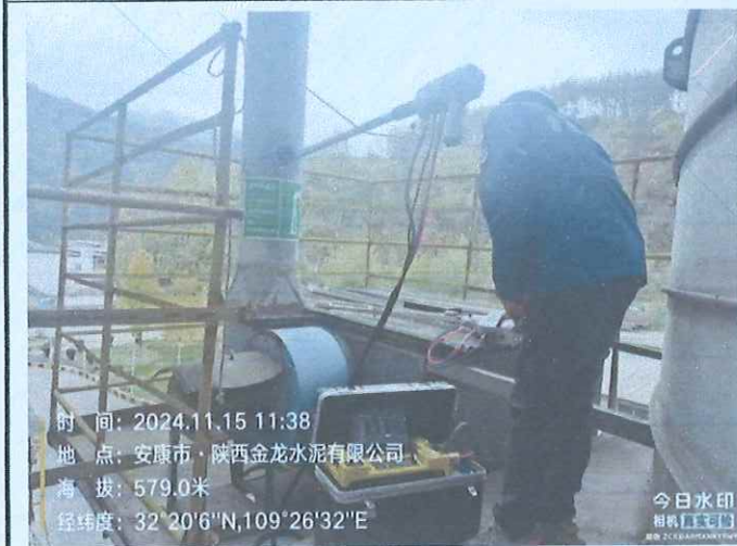
水泥装九废气排气筒 (DA062)
